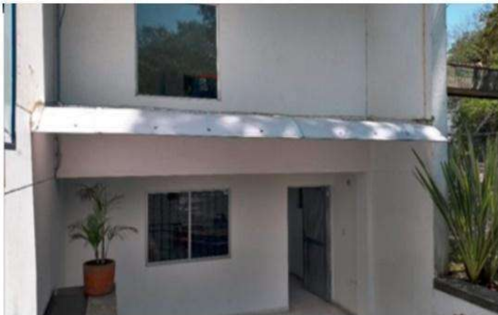
Construcción de la Unidad Técnica de Residuos en el edificio de la Vicerrectoría de Investigaciones de la Universidad del Cauca de acuerdo a las especificaciones y cantidades establecidas en el anexo n° 03.
