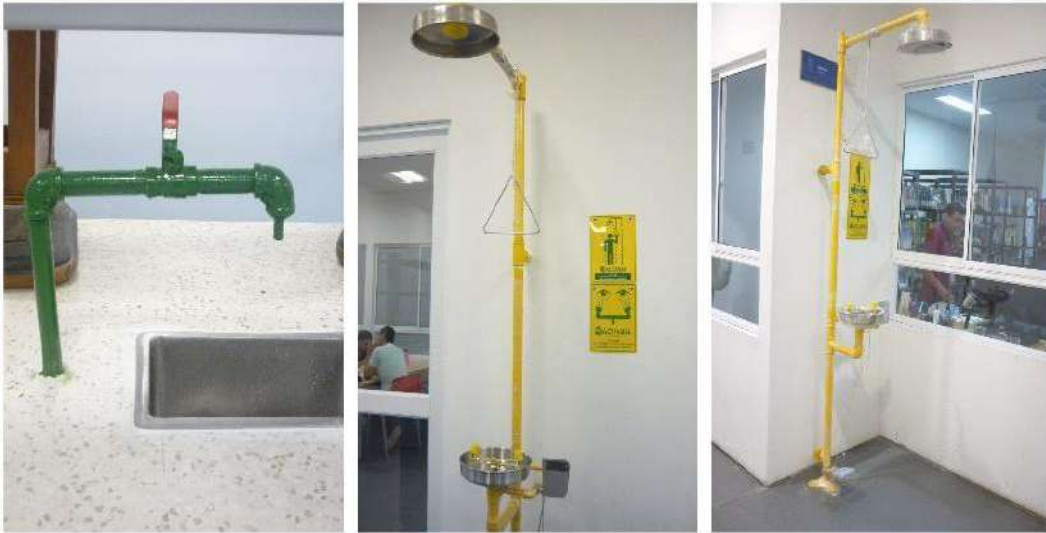
Adecuaciones locativas de las oficinas de ASPU.
